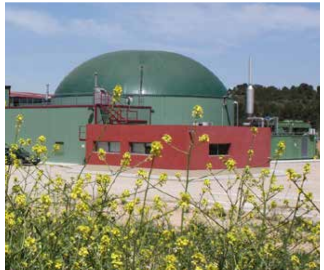
Planta de biogás. Foto: Granja San Ramón
