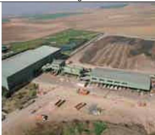
Vista general de las instalaciones
